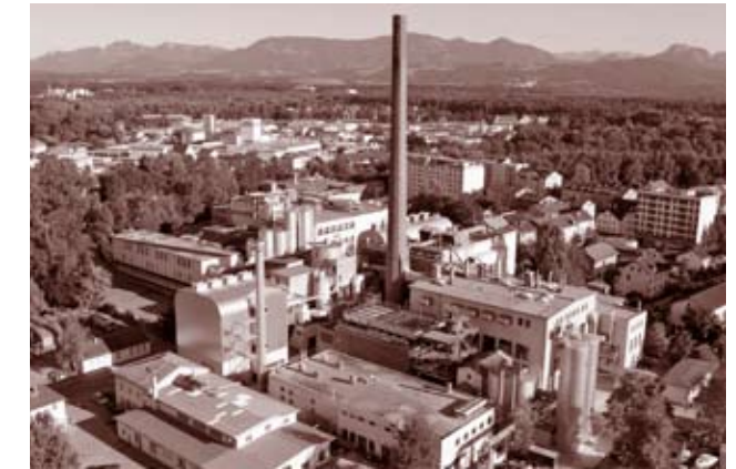
Energienutzung aus Rauchgas – Das moderne Rauchgasreinigungssystem des MHKW Rosenheim nimmt nachhaltig Einfluss auf die Energieeffizienz.
